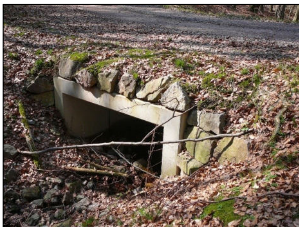
Abbildung 10: Neu gestaltetes Durchlassbauwerk oberhalb Meierwiese bei Bringhausen
