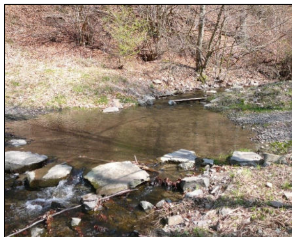
Abbildung 11: Anlage einer Furt im mittleren Keßbachtal
