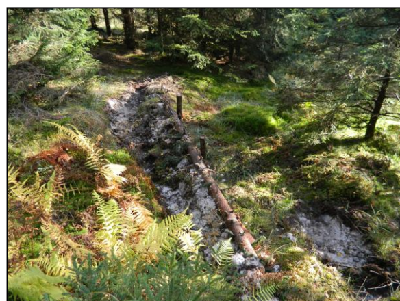
Abb. 11: Der Einbau von Abschlügen zur Renaturierung des Wasserabflusses wurde an zahlreichen Stellen realisiert
