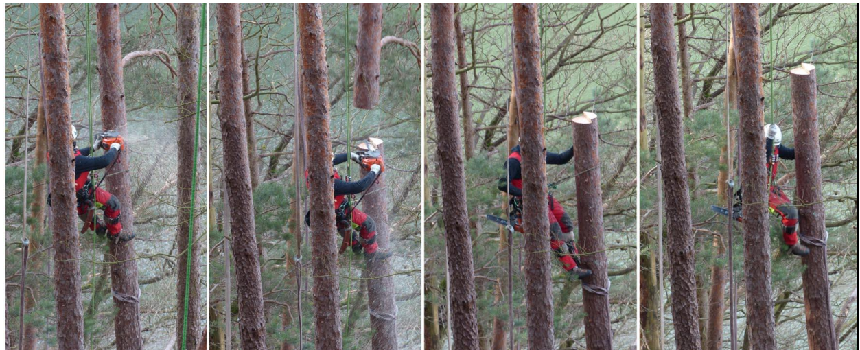
Abb. 24: Der Baum wird vom Kletterer auf halber Höhe geteilt – dann Abflug in zwei Teilen; Arbeit auf halber Höhe
