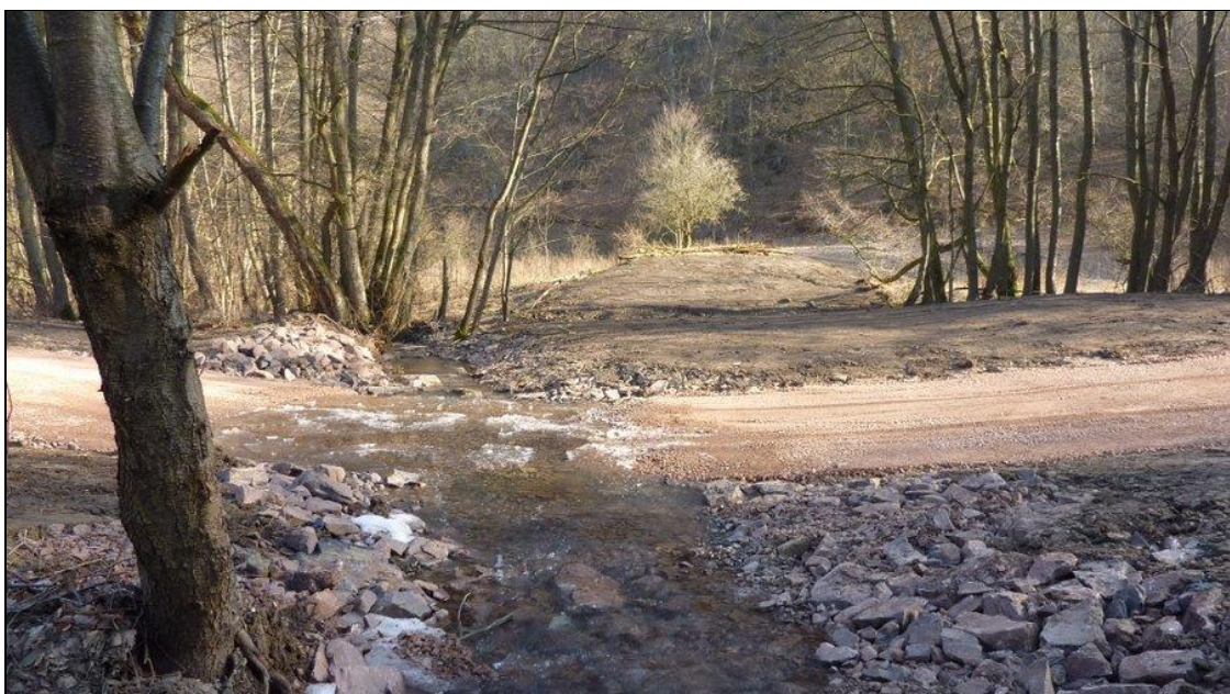
Abb. 19: Renaturierter Bachabschnitt des Banfebach nach Entnahme der Verrohrung und Umwandlung in eine offene Furt.
