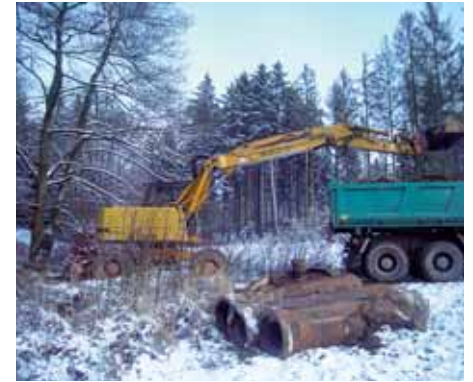
Abfuhr von alten Rohrdurchlässen
