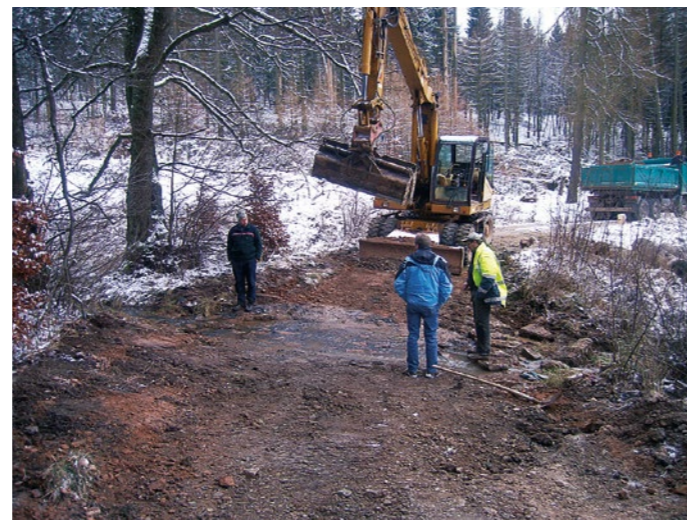
Im Nationalpark wurden Fließgewässer renaturiert, Verrohrungen entfernt und Furten angelegt.
